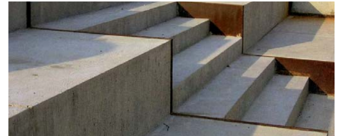
Platsgjuten betongtrappa med kantstöd av corténplåt
